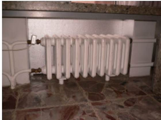
Südfenster mit Isolierplatte aus Styropor
