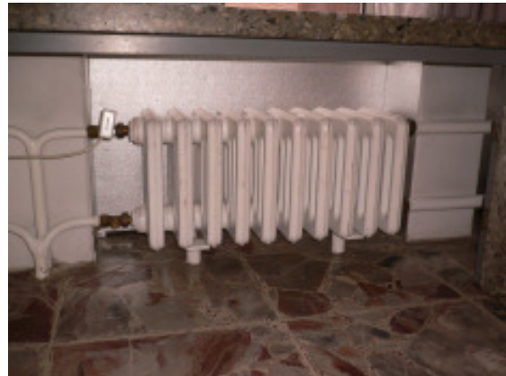
Südfenster mit Isolierplatte aus Styropor
