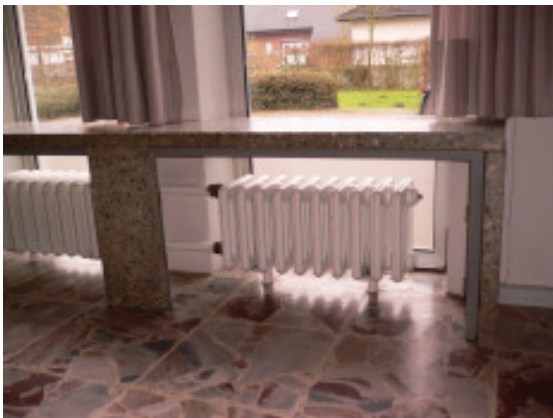
Südfenster ohne Isolierplatte
